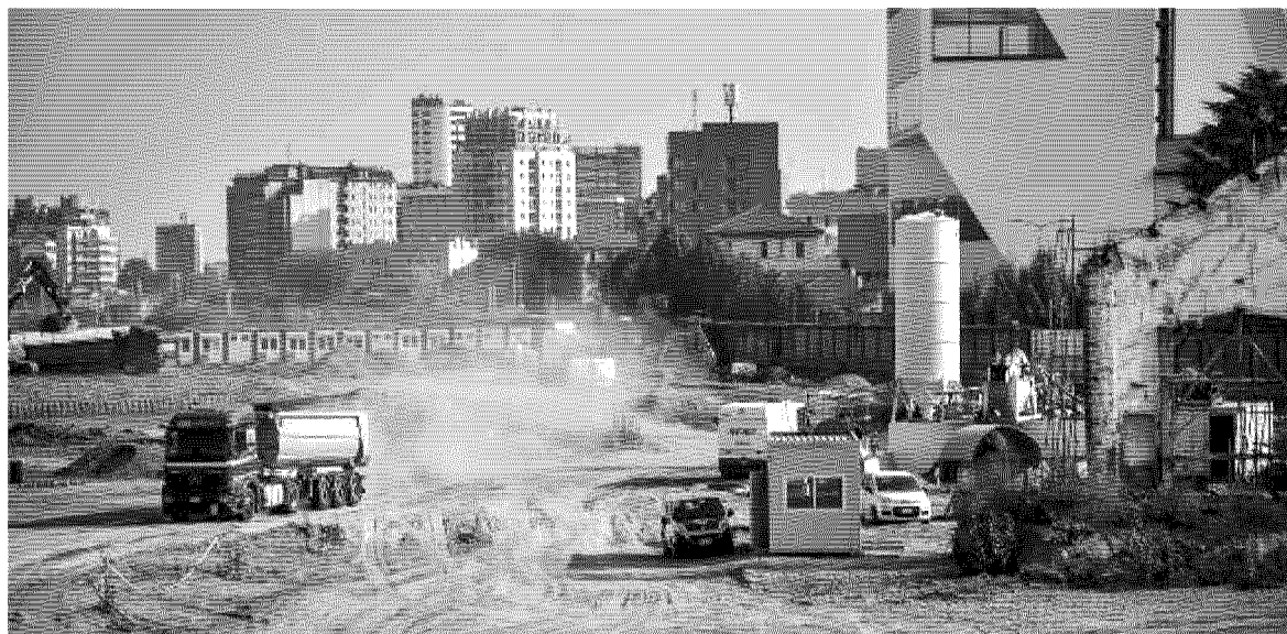
I cantieri per il villaggio olimpico per i giochi invernali di Milano-Cortina 2026 allo scalo di Porta Romana
