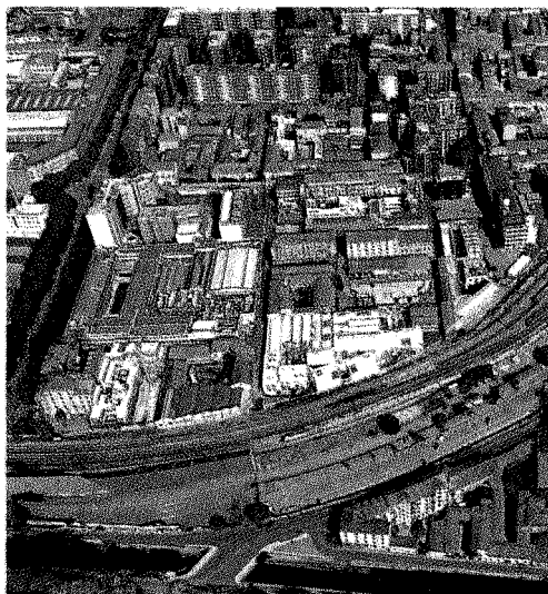
Una immagine aerea dello scalo di Porta Genova
